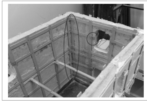
Figura 20. Unión entre esquinas, puertas y ventanas
