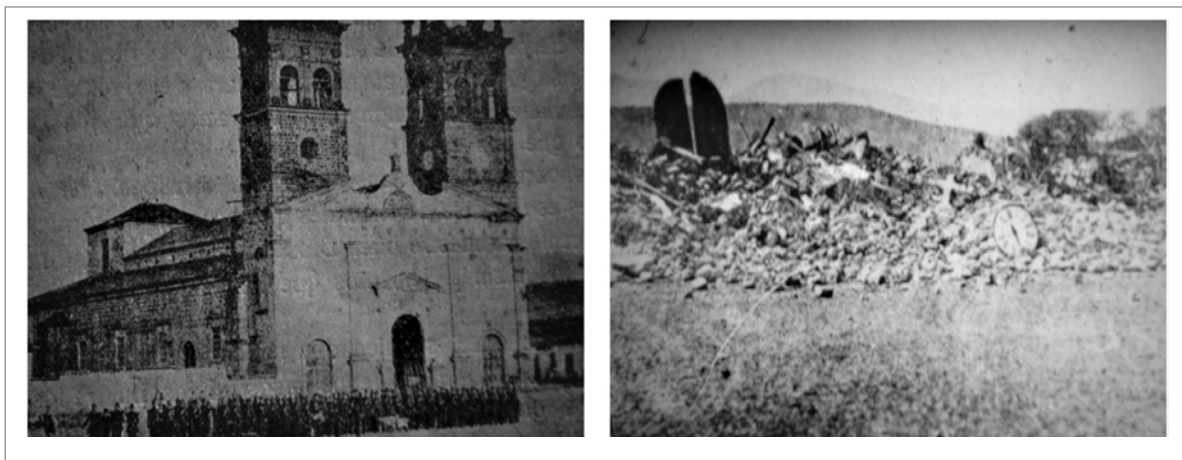
Figura 2. Colapso de la Iglesia de Cúcuta (en tierra) durante el terremoto de 1875 Tomado de (Ruiz et. al., 2012)
