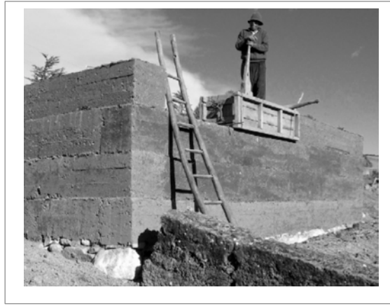
Figura 1. Proceso constructivo de la tapia pisada (Chang et al., 2013)
