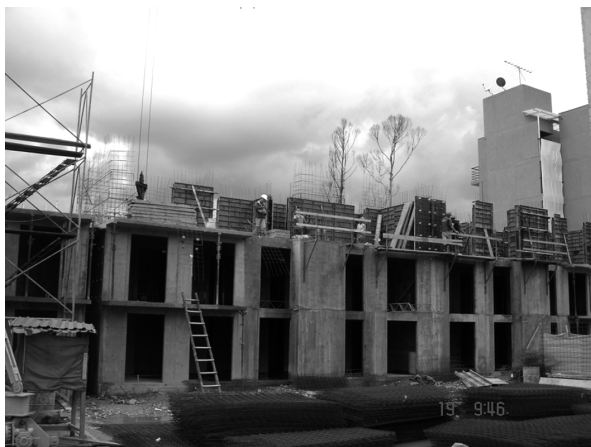
Figura 3. Torre típica en su fase de construcción de estructura
