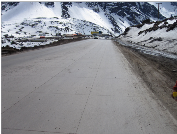
Figura 10. 15cm hormigón con fibra y diseño TCP en la Ruta 60 para 20.000.000 de EE (2 años en servicio) Figure 10. 15 cm of fiber reinforced concrete and TCP design on 60th Road for 20,000,000 EA (2 years in service)
