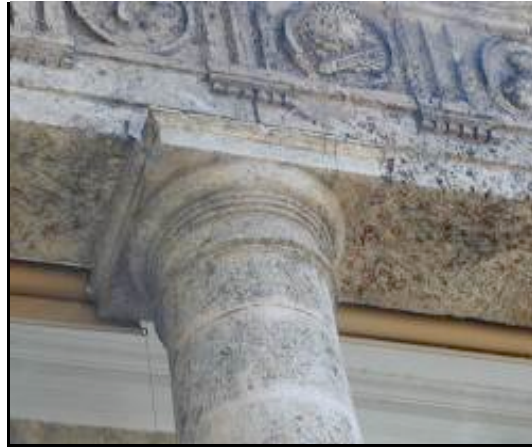
Figura 3. Destalle del capitel en las columnas Figure 3. Details of column caps
