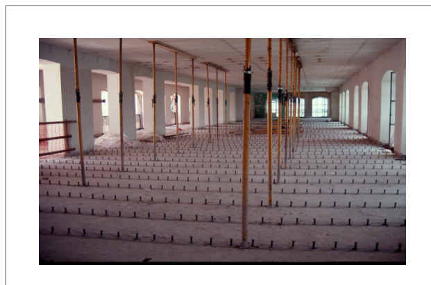
Figura 10. Fotografía de la obra antes del hormigonado Figure 10. Picture of the works before concrete cast-in
