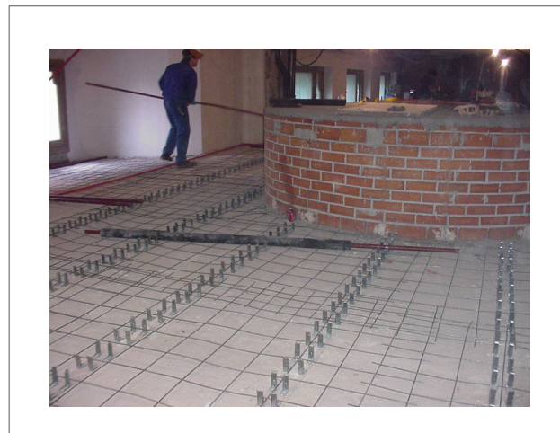
Figura 9. Fotografía de la obra antes del hormigonado Figure 9. Picture of the intervention before concrete cast-in
